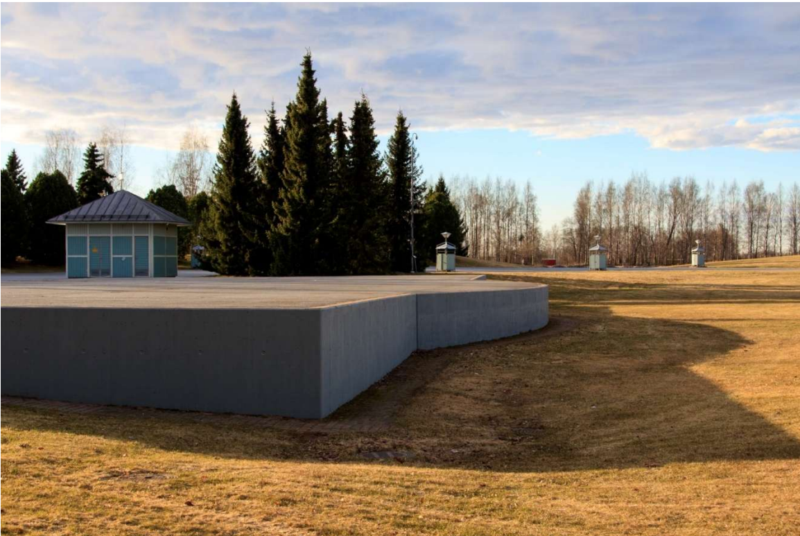
Kuva 3. Porin Delta-areenan päälavan perusta. Kuva otettu 15. huhtikuuta 2026. Lähde: Jarmo Karonen.
